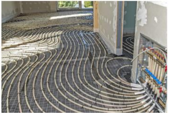
Vloerverwarmingsbuizen “nat systeem” alvorens aanbrengen dekvloer
