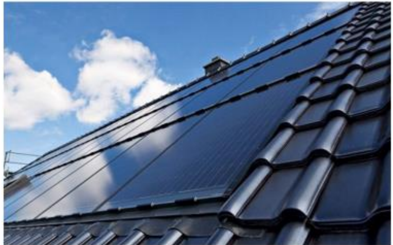
Zonnepanelen tussen dakbedekking (Bron: www.zonnepaneelprijzen.nl )
