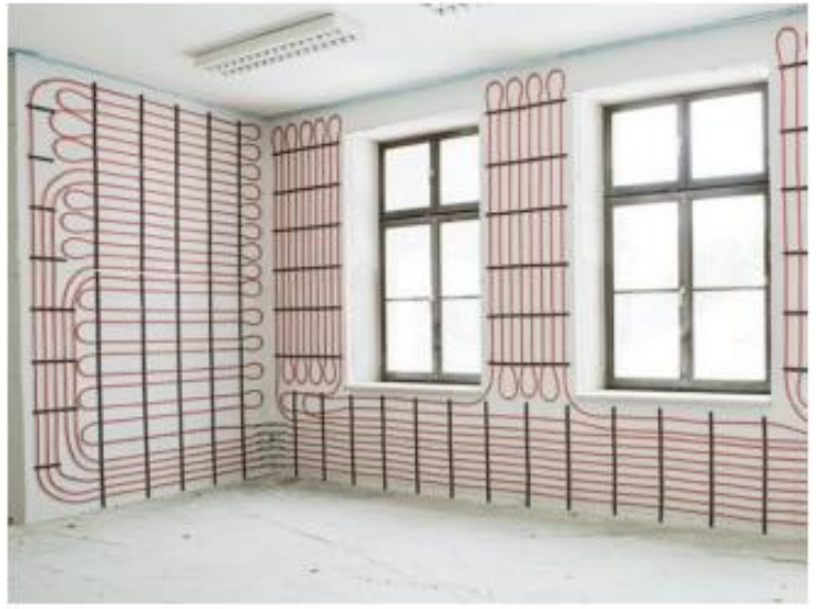
Wandverwarmingsbuizen alvorens aanbrengen stuclaag
